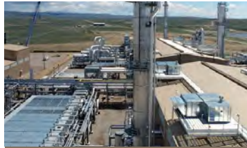
Frimont, Vayominq Lost Cabinde yeni təsis olunmuş turşu qazların şirirləşdirilməsi obyektini üçün layihələndirmənin ilkin mərhələsindən son mərhələsinədək mühəndislik və inşaat sahələrinin bütün aspektləri üzrə məsuliyyət daşımışdır.
